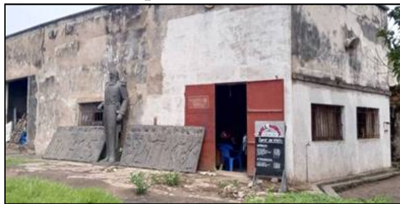
Vétusté, manque d'infrastructures... le Musée national de Kananga tire la sonnette d'alarme. PHOTO DROITS FDA
